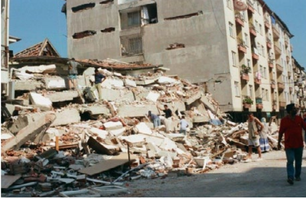
Şekil 8. Ahşap ve betonarme yapıların deprem sonrası durumları (Soldaki ahşap yapı, sağdaki betonarme yapı)
