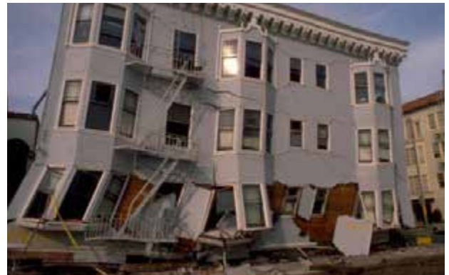
Şekil 8. Ahşap ve betonarme yapıların deprem sonrası durumları (Soldaki ahşap yapı, sağdaki betonarme yapı)
