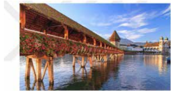
Şekil 1.1: Chapel Köprüsü, Luzern/İsviçre, yapım:1333 (Url 1).
